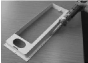
1. Imperméabiliser le cadre d'installation ;
